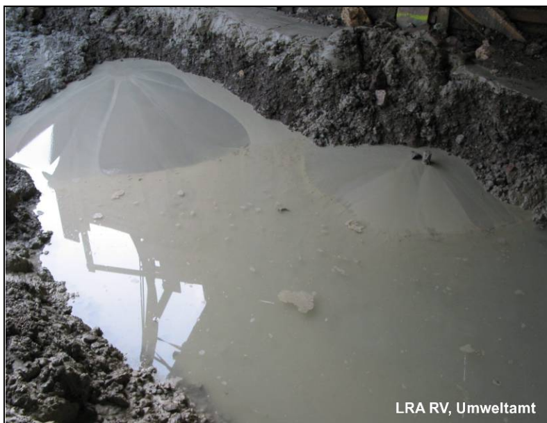
Abbildung 5-4: Artesischer Grundwasseraustritt mit Ausspülung von Feinmaterial (Quelle: LRA RV).
