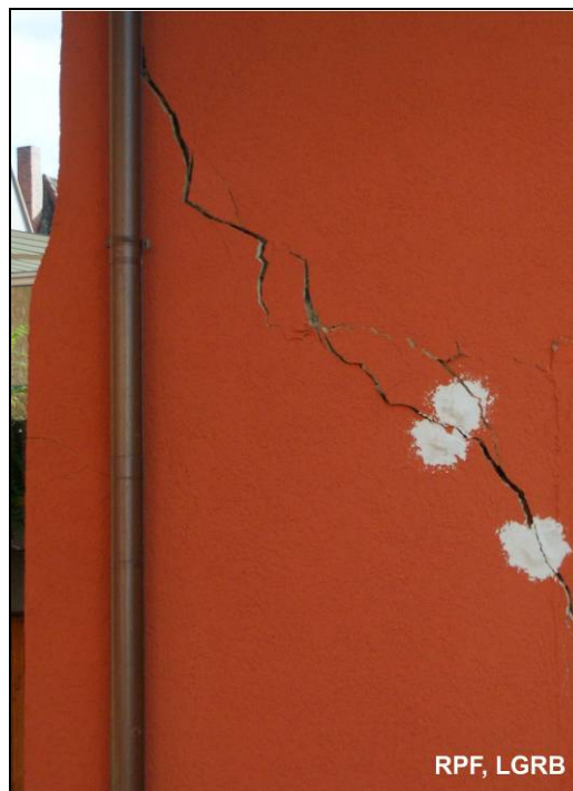
Abbildung 5-9: Hebungsrisse an Gebäuden in Staufen i. Br. (Quelle: LGRB)
