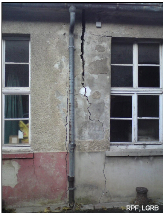
Abbildung 5-9: Hebungsrisse an Gebäuden in Staufen i. Br. (Quelle: LGRB)
